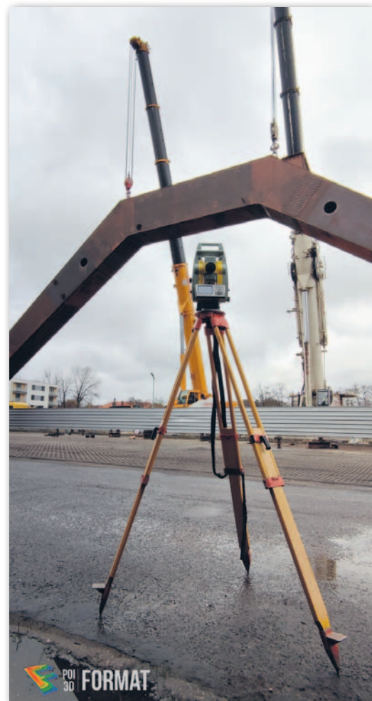
Kontrola 120-tonowej konstrukcji stalowej
